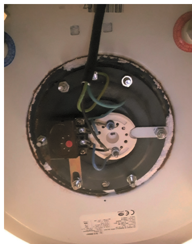
Résistance stéatite et thermostat de chauffe-eau réglable
