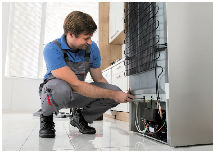
Groupe compresseur (en bas) et son refroidisseur au dos de l'appareil
