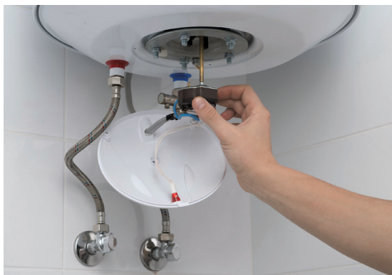
Extraction d'un thermostat
