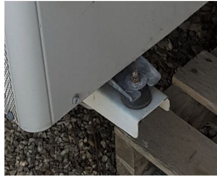
Silentbloc de fixation d'une unité extérieure
